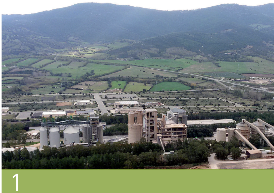
1. LO STABILIMENTO DI SINISCOLA CON I NUOVI SILI CLINKER PER L'OWC THE SINISCOLA PLANT WITH THE NEW CLINKER SILOS FOR THE OWC
